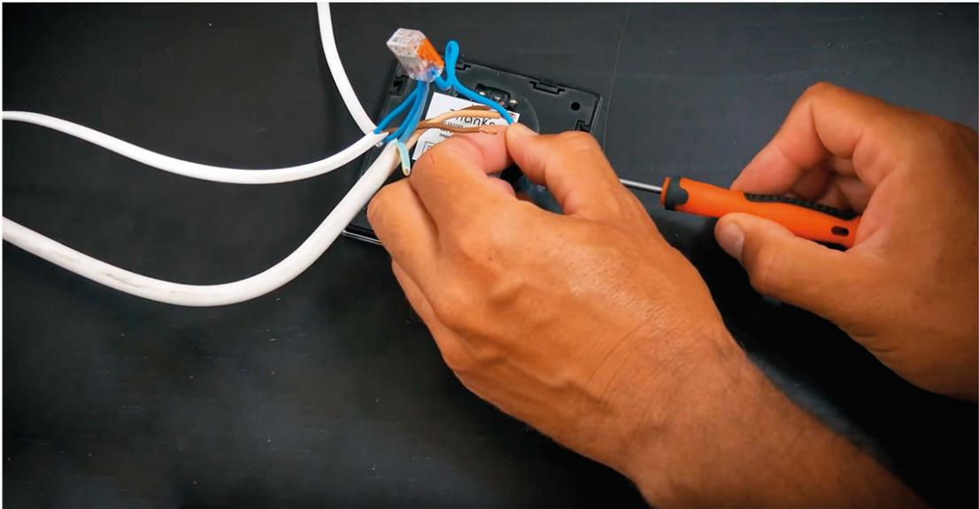
Raccorder le fil de la Phase relié au tableau électrique.
