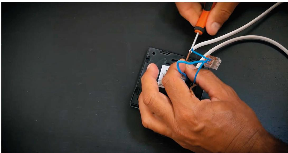
Raccorder le fil de la Phase qui part vers le luminaire.
